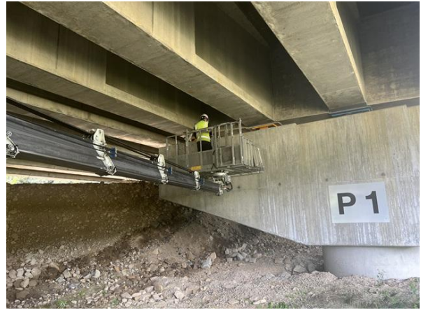
고소점검차를 이용한 근접조사
