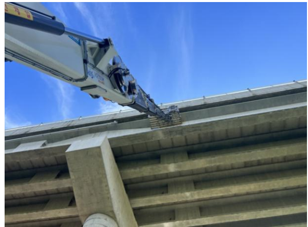
고소점검차를 이용한 근접조사
