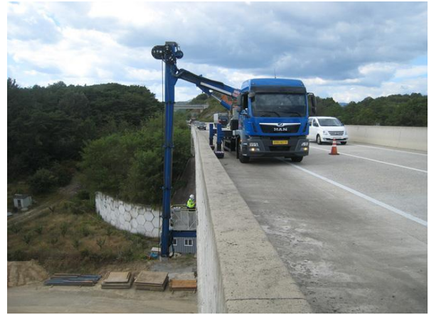
교량점검차를 이용한 근접조사
