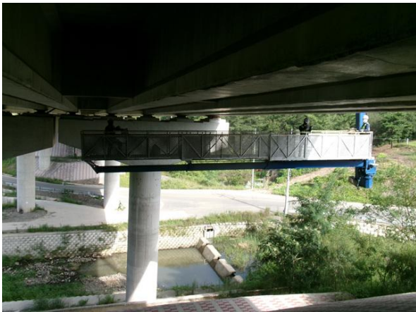
굴절점검차를 이용한 근접조사
