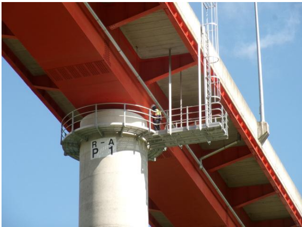
점검통로를 이용한 근접조사
