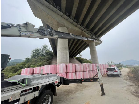
고소점검차를 이용한 근접조사
