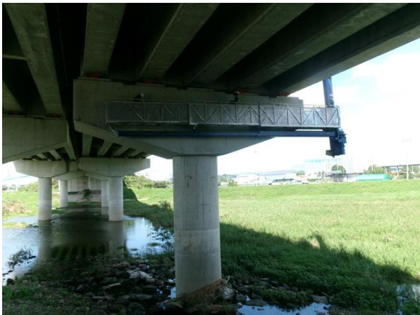
굴절점검차를 이용한 근접조사
