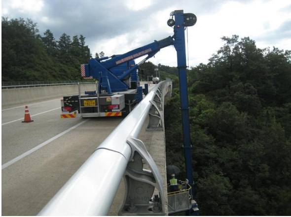
굴절점검차를 이용한 근접조사
