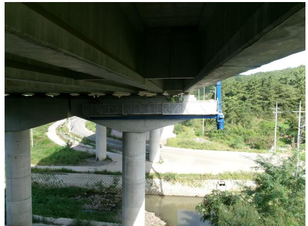
굴절점검차를 이용한 근접조사
