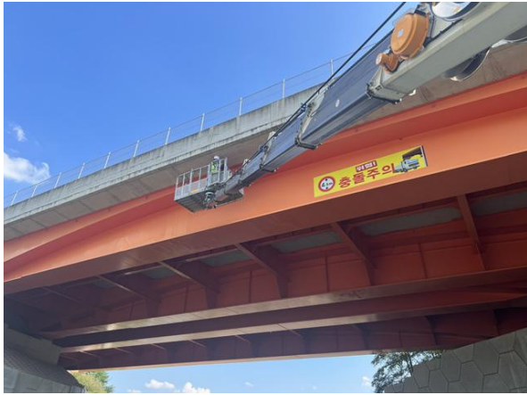
고소점검차를 이용한 근접조사
