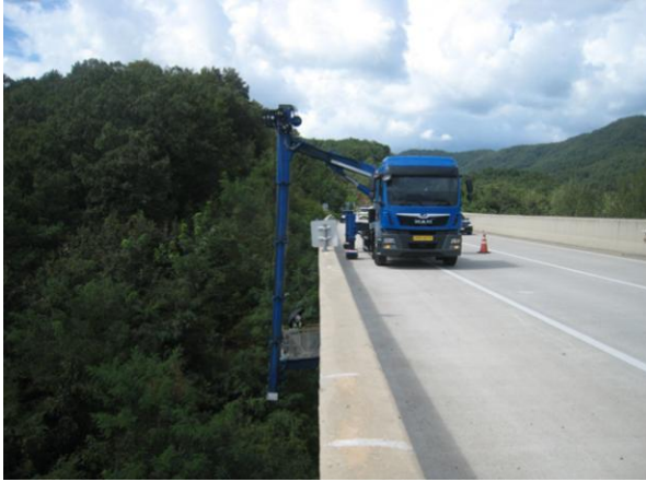
굴절점검차를 이용한 근접조사
