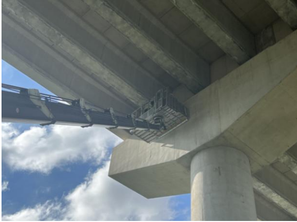
고소점검차를 이용한 근접조사
