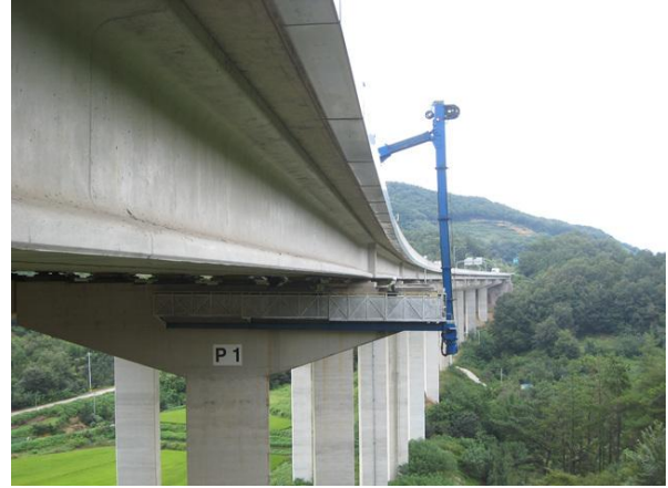
굴절점검차를 이용한 근접조사
