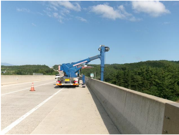
굴절점검차를 이용한 근접조사
