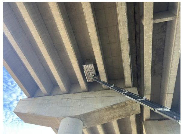
고소차를 이용한 근접조사
