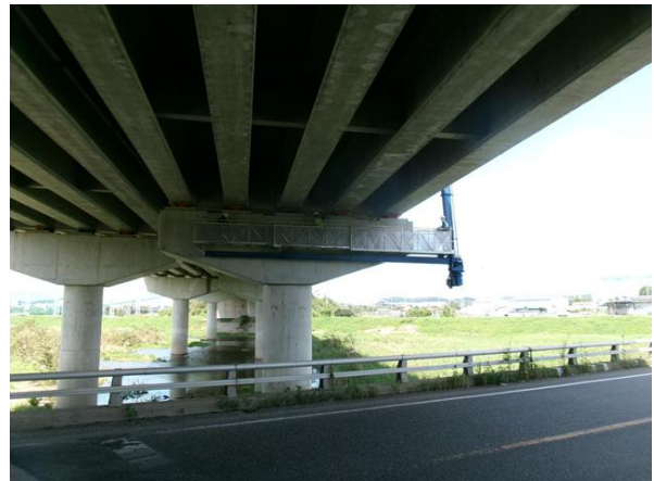
굴절점검차를 이용한 근접조사
