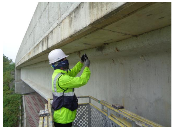
탄산화 깊이 측정
