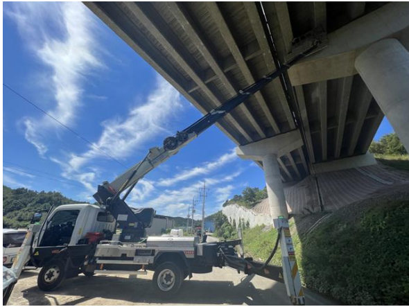
고소차를 이용한 근접조사
