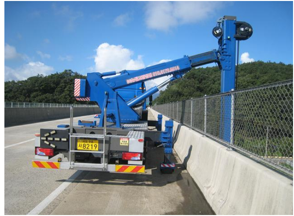
교량점검차를 이용한 근접조사
