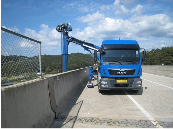
굴절점검차를 이용한 근접조사
