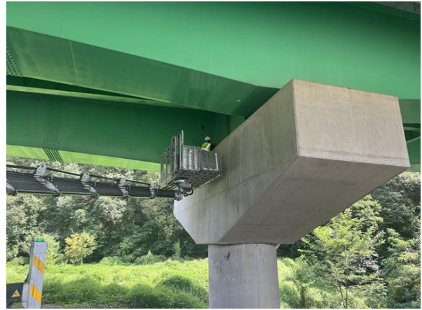
고소점검차를 이용한 근접조사
