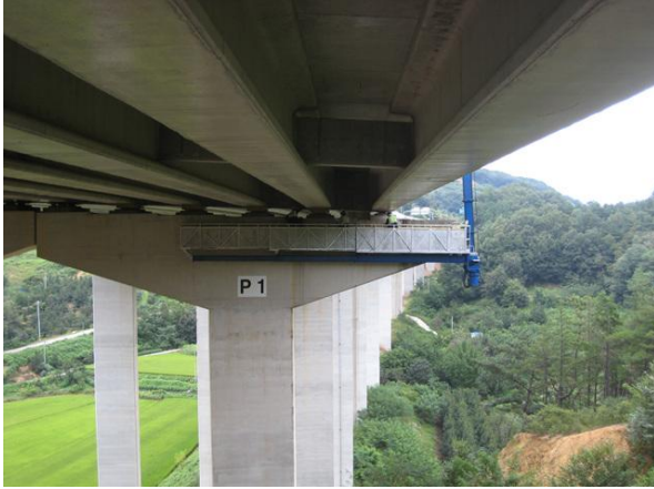
굴절점검차를 이용한 근접조사
