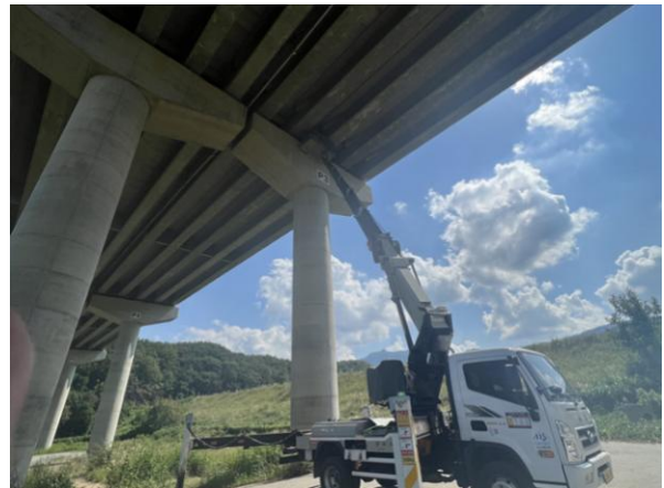
고소점검차를 이용한 근접조사
