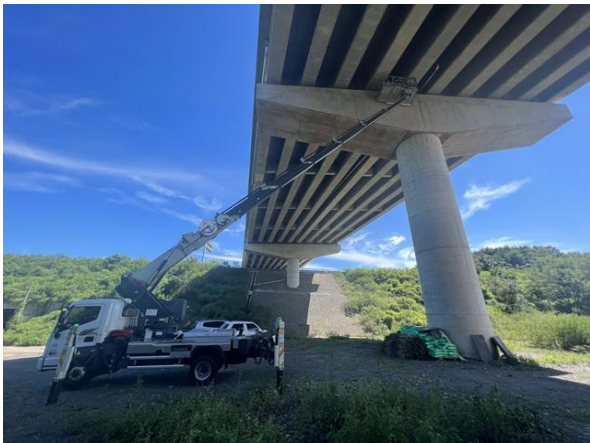
고소점검차를 이용한 근접조사
