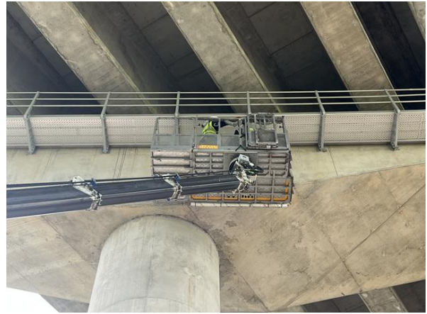
고소점검차를 이용한 근접조사
