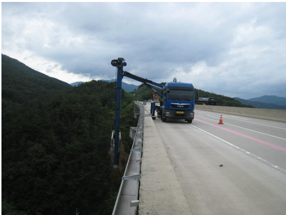
굴절점검차를 이용한 근접조사
