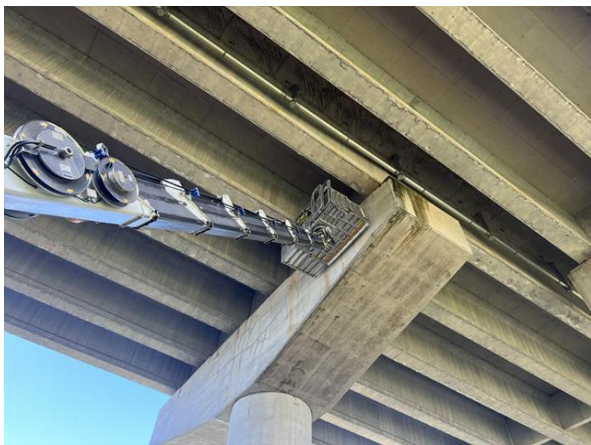
고소차를 이용한 근접조사
