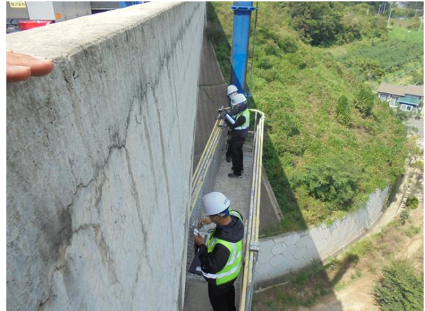
교량점검차를 이용한 근접조사
