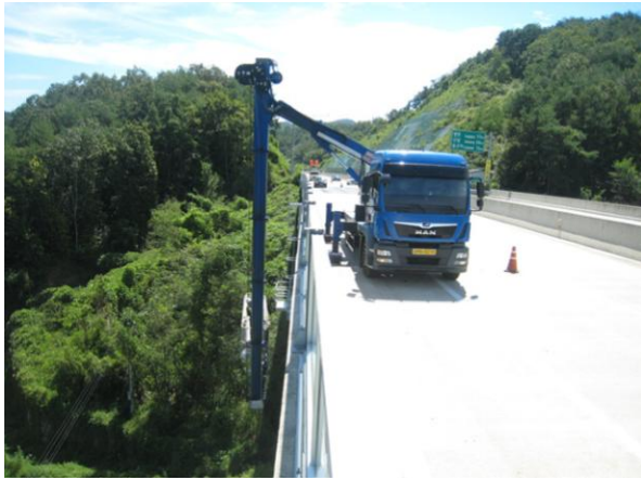
굴절점검차를 이용한 근접조사
