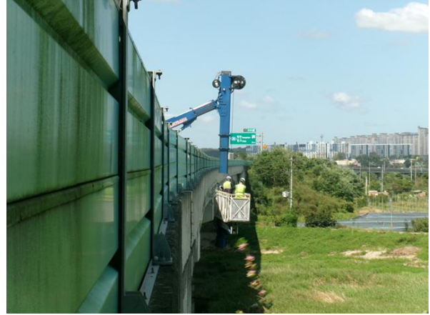
굴절점검차를 이용한 근접조사
