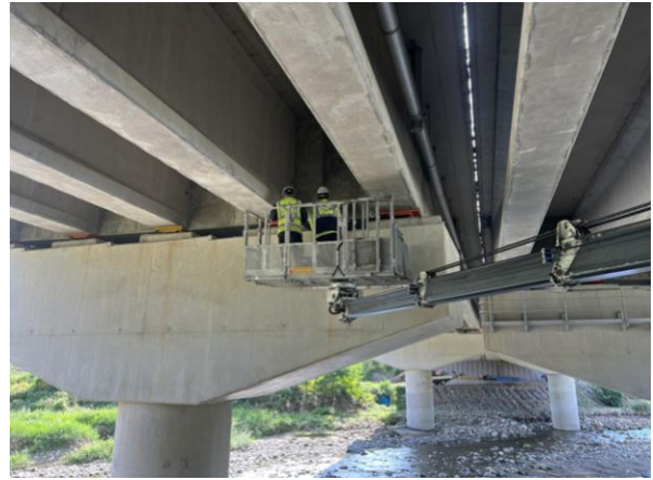
고소점검차를 이용한 근접조사
