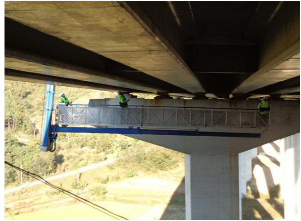
굴절점검차를 이용한 근접조사
