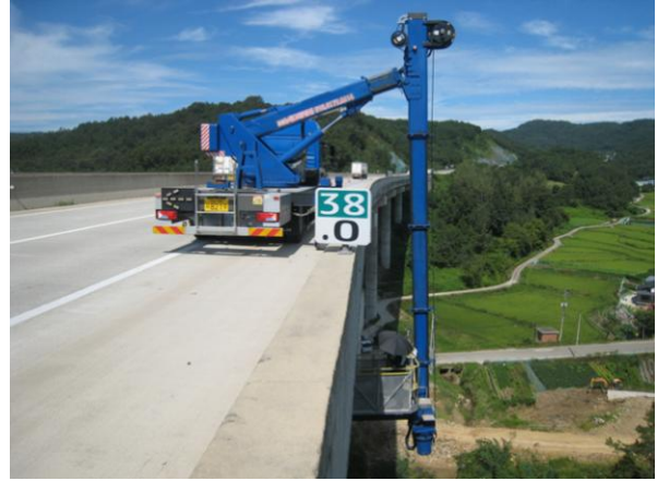
굴절점검차를 이용한 근접조사
