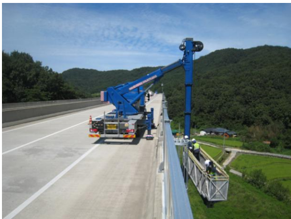
굴절점검차를 이용한 근접조사
