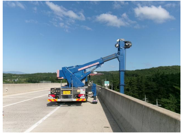
굴절점검차를 이용한 근접조사
