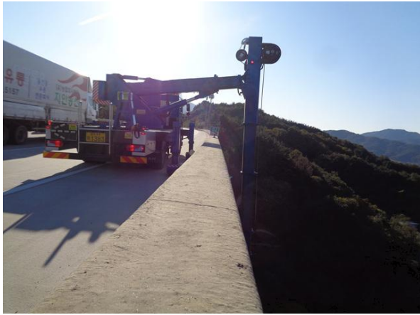
굴절점검차를 이용한 근접조사
