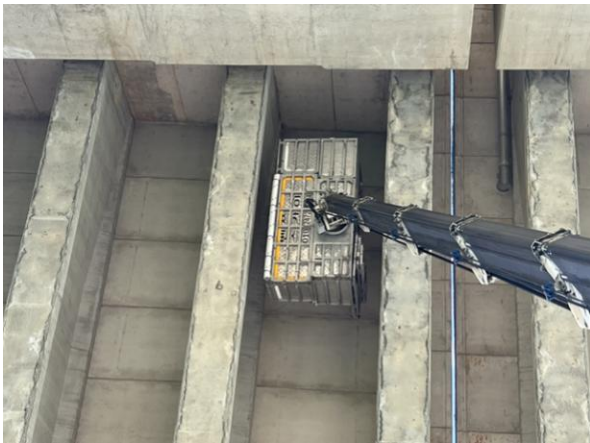
고소점검차를 이용한 근접조사
