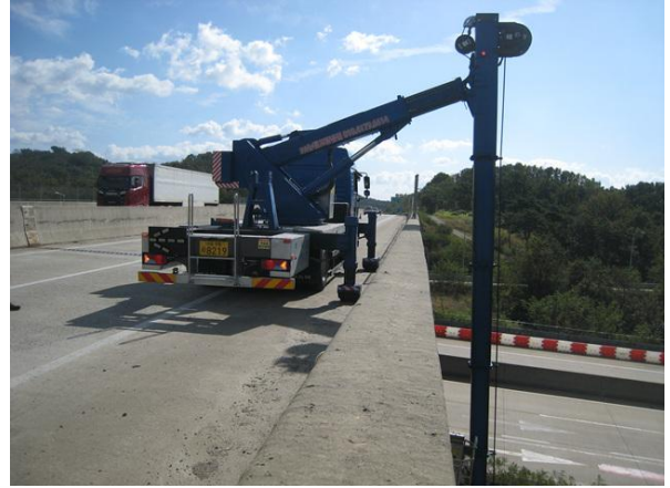
굴절점검차를 이용한 근접조사
