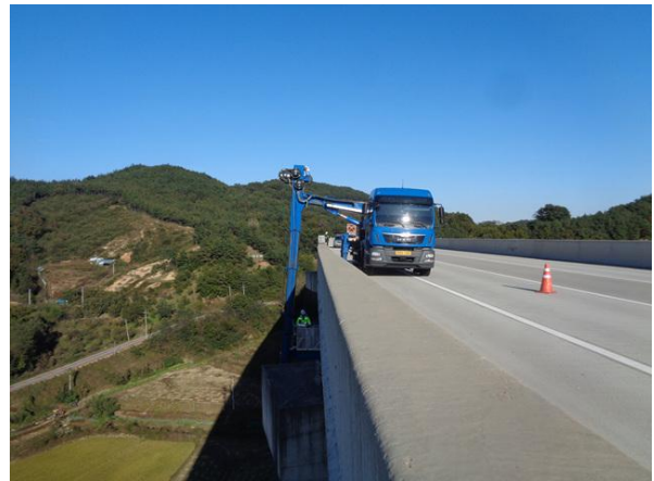
굴절점검차를 이용한 근접조사
