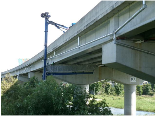
굴절차를 이용한 근접조사
