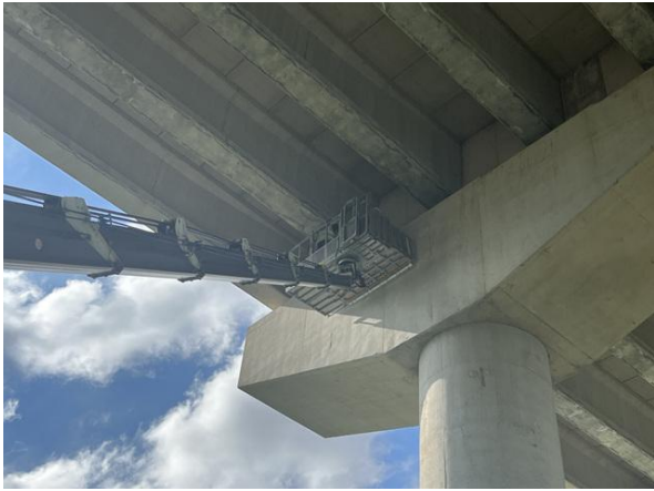
고소점검차를 이용한 근접조사
