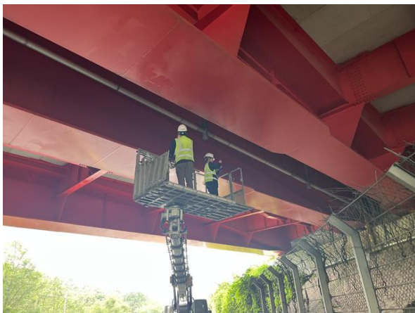
고소차를 이용한 근접조사
