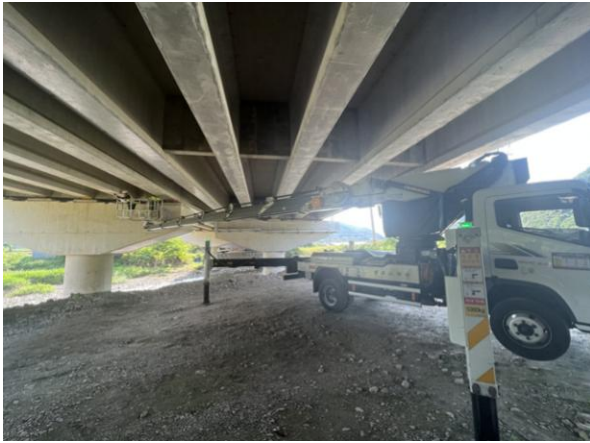
고소점검차를 이용한 근접조사
