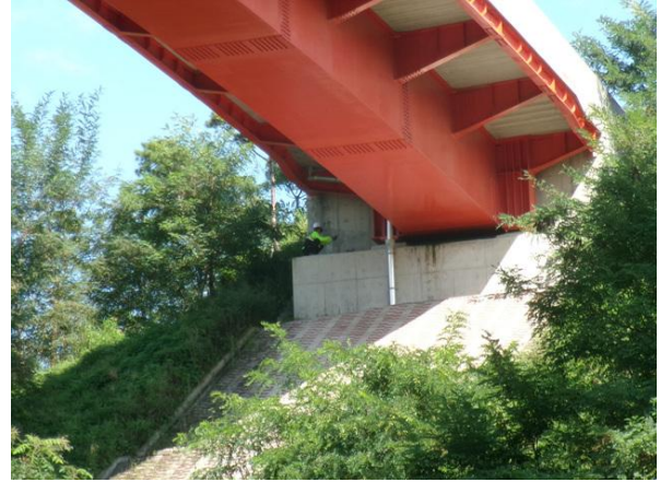
도보를 이용한 외관조사
