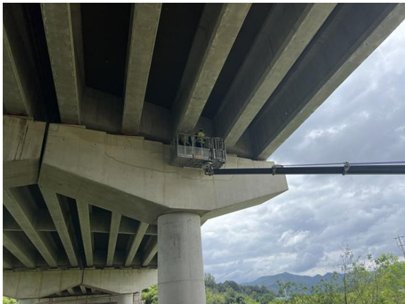
고소점검차를 이용한 근접조사
