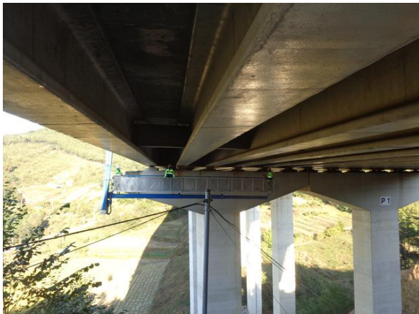
굴절점검차를 이용한 근접조사
