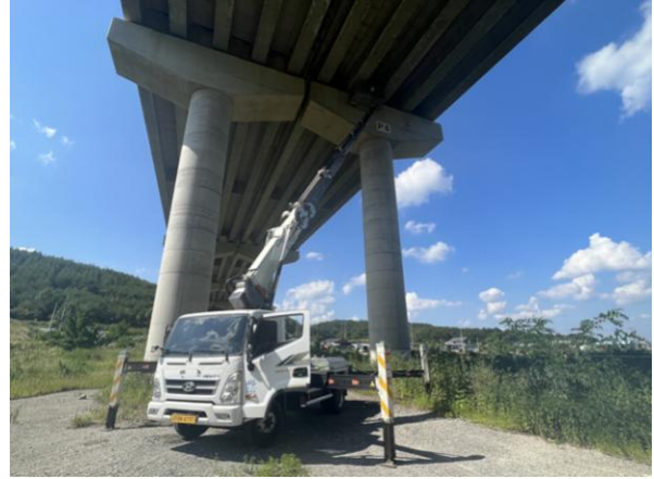
고소점검차를 이용한 근접조사
