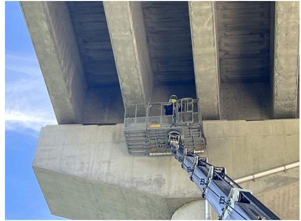
고소차를 이용한 근접조사
