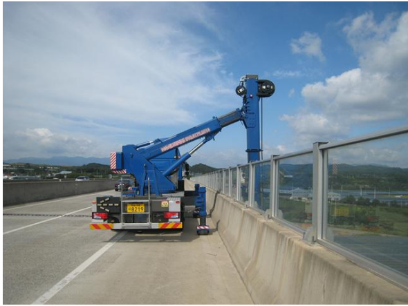
교량점검차를 이용한 근접조사
