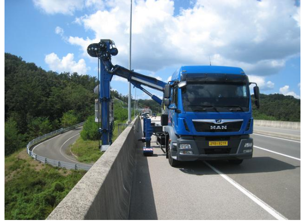
굴절차를 이용한 근접조사
