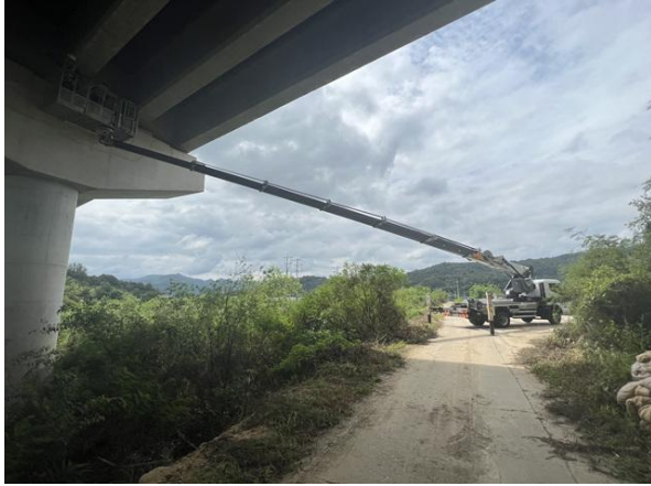
고소점검차를 이용한 근접조사
