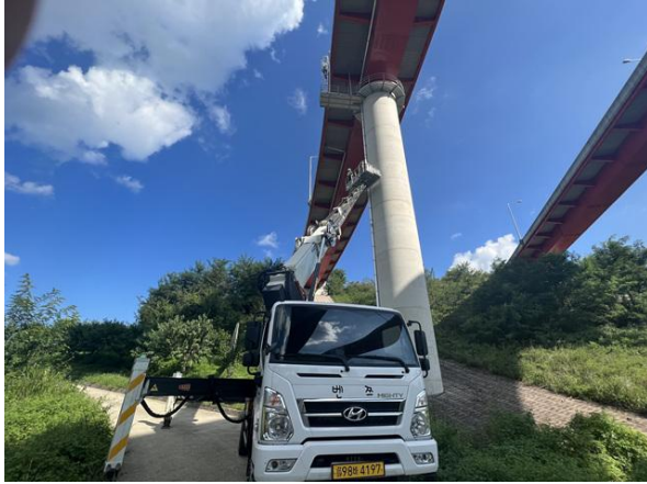
고소차를 이용한 외관조사
