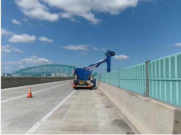
굴절점검차를 이용한 근접조사
