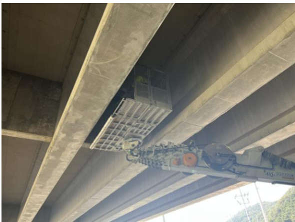
고소점검차를 이용한 근접조사
