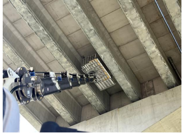
고소점검차를 이용한 근접조사
