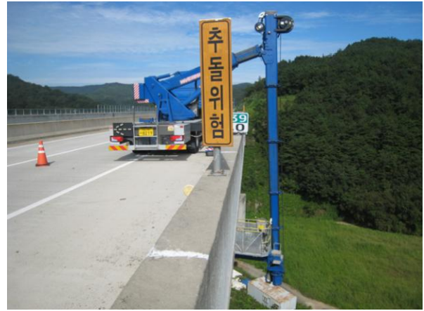
굴절점검차를 이용한 근접조사
