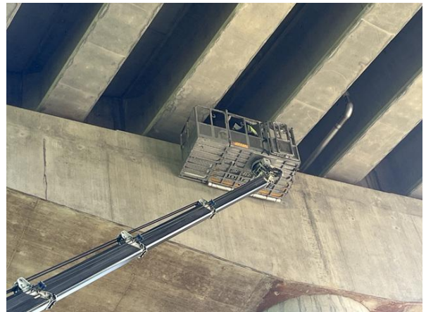
고소점검차를 이용한 근접조사
