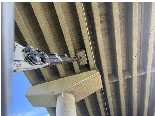
고소차를 이용한 근접조사
