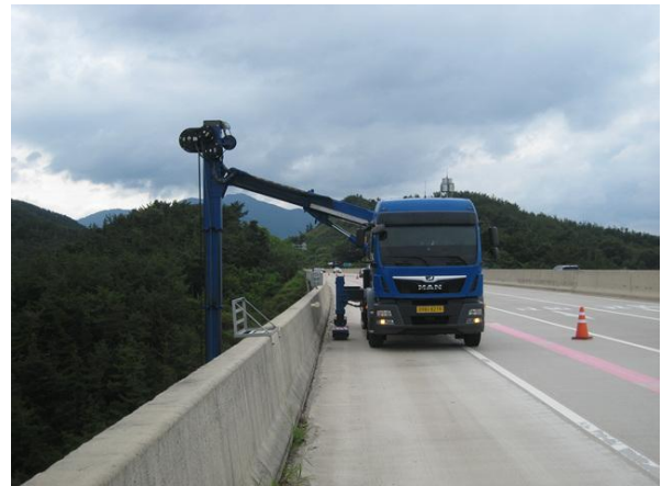
굴절점검차를 이용한 근접조사
