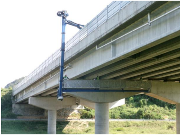
굴절점검차를 이용한 근접조사
