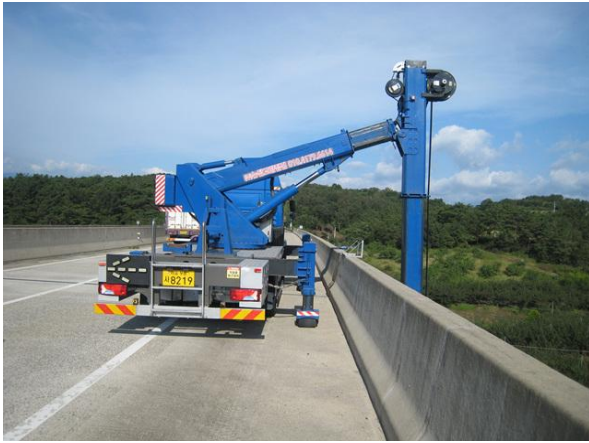
교량점검차를 이용한 근접조사
