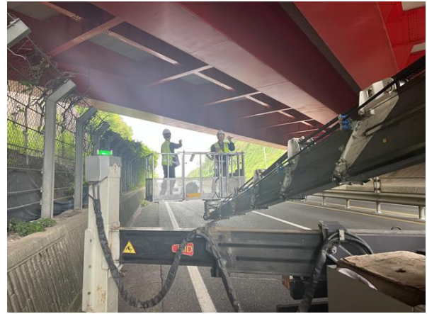
고소차를 이용한 근접조사
