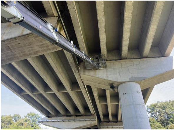
고소차를 이용한 근접조사
