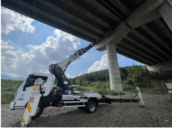
고소점검차를 이용한 근접조사
