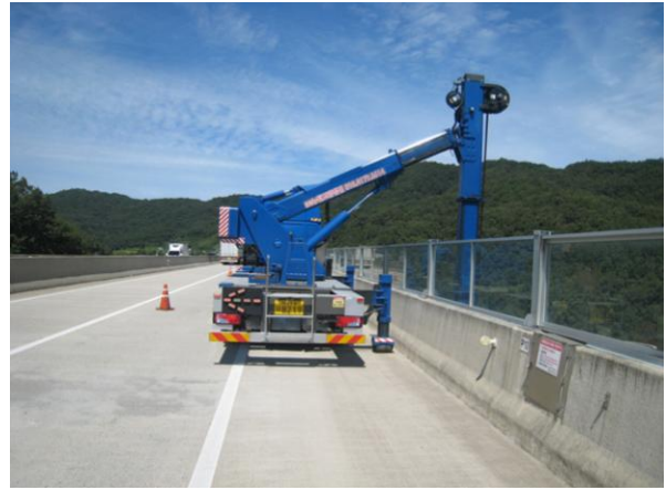
굴절점검차를 이용한 근접조사
