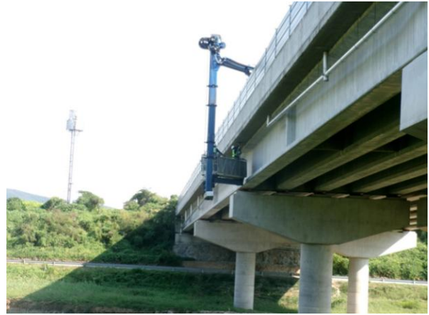
굴절점검차를 이용한 근접조사
