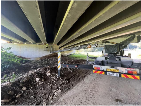
고소점검차를 이용한 근접조사
