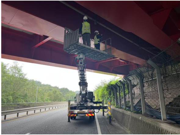
고소차를 이용한 근접조사
