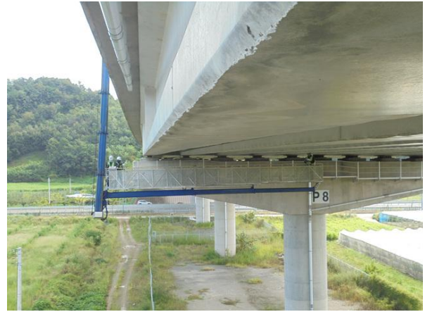
교량점검차를 이용한 근접조사
