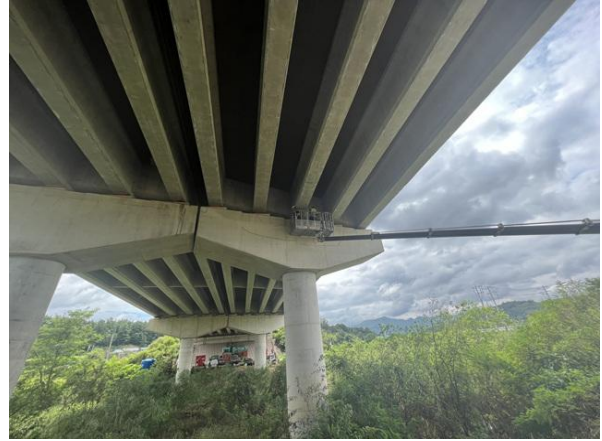
고소점검차를 이용한 근접조사
