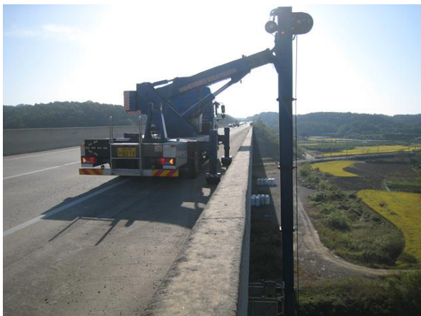
교량점검차를 이용한 근접조사
